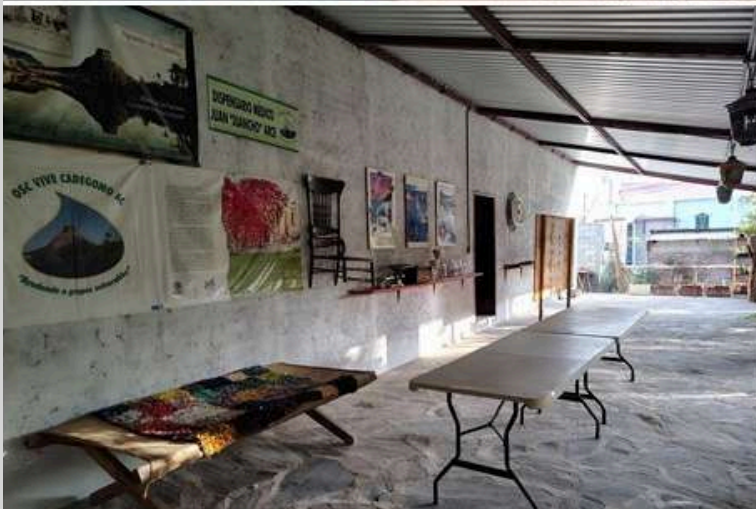
Equivalente después de la remodelación
